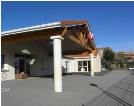
Ecole Publique « Saint Exupéry » Source : Site internet de l'école primaire
